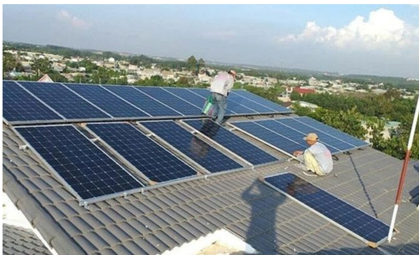
人們安裝屋頂太陽能發電系統。圖片來源：VNExpress
